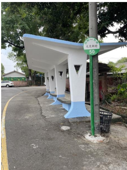
說明：光復新村建物景觀 1
